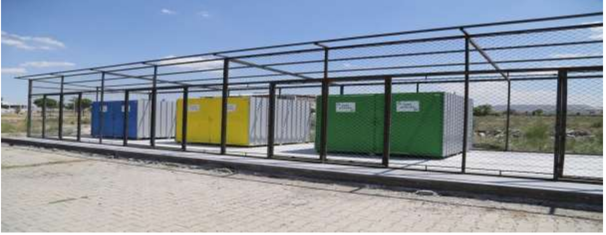
Resim 12. Sıfır Atık Projesi (Atık Toplama Alanı)
